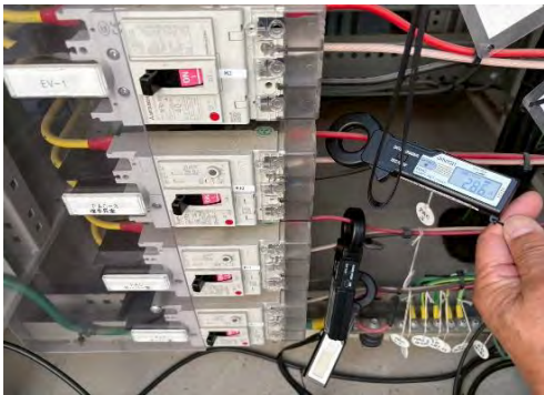
分電盤内に測定器ロガーを取付
